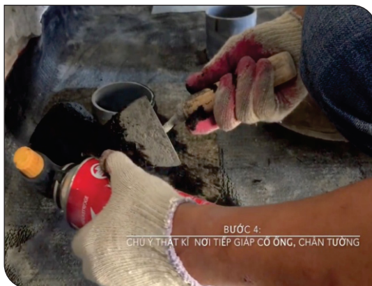
Xử lý cổ ống thoát nước
