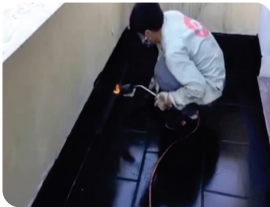
Xử lý góc chân tường
