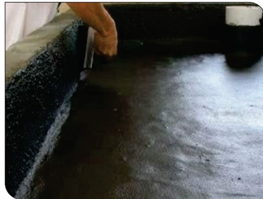
Thi công lăn lớp lót
