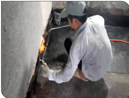
Thi công màng khô nóng
