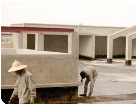
Thi công màng khô nóng
