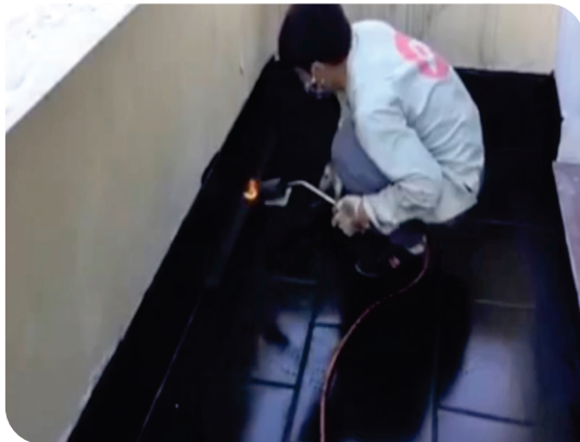
Xử lý góc chân tường
