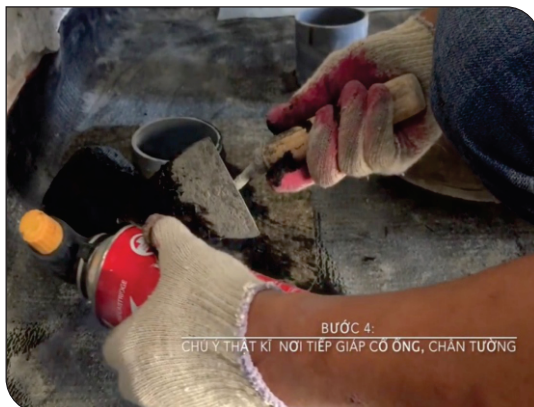
Xử lý cổ ống thoát nước
