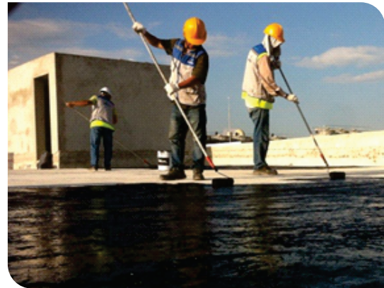
Thi công lăn lớp lót
