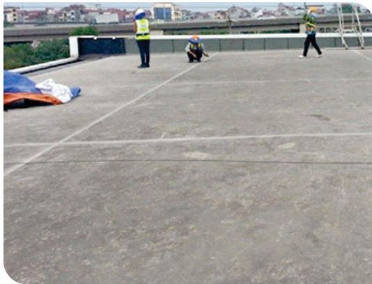
Chuẩn bị bề mặt
