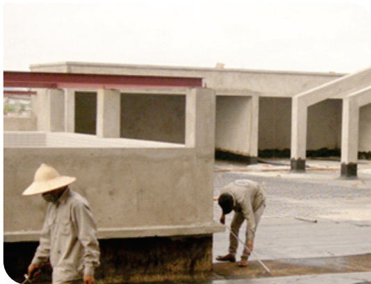
Thi công màng khô nóng
