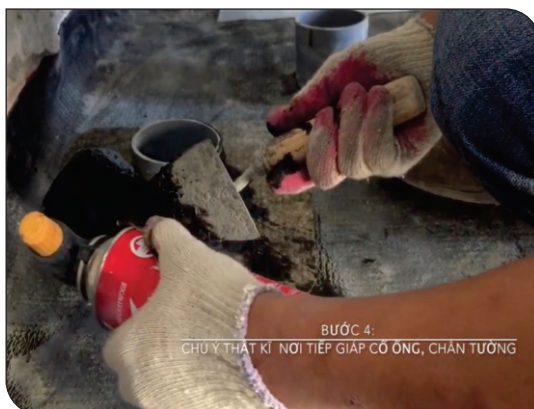
Xử lý cổ ống thoát nước
