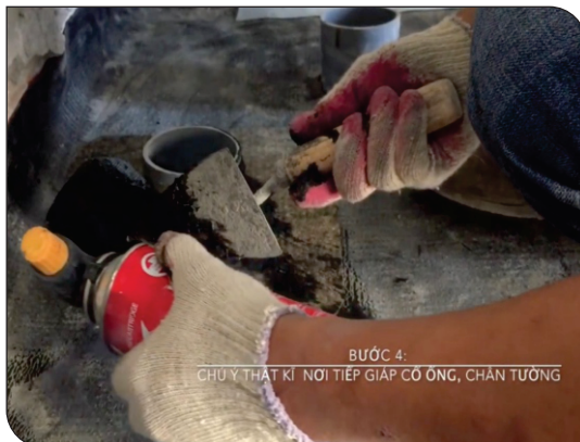
Xử lý cổ ống thoát nước
