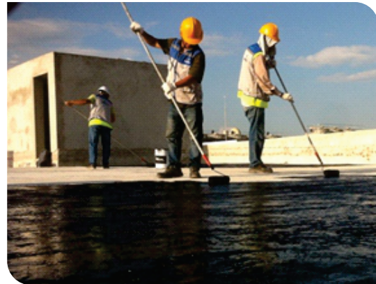
Thi công lăn lớp lót
