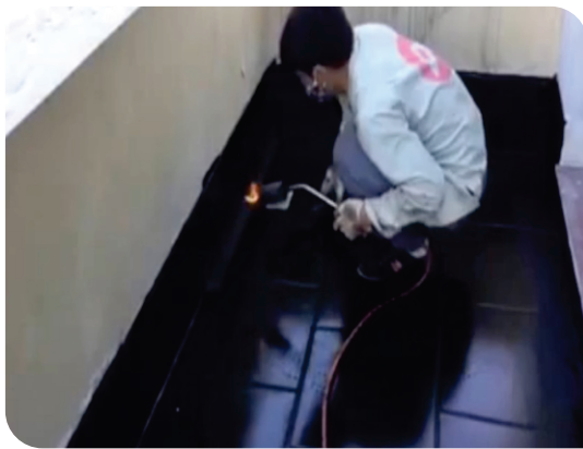
Xử lý góc chân tường
