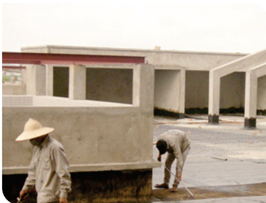
Thi công màng khò nóng
